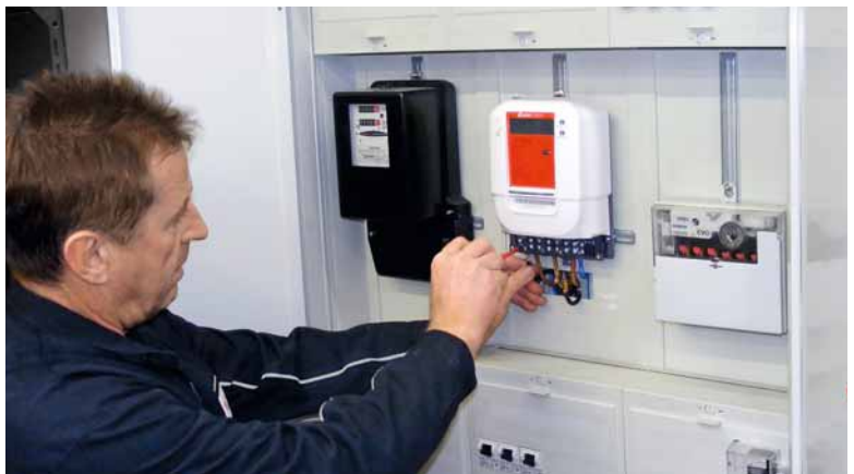
Installation eines intelligenten Stromzählers
