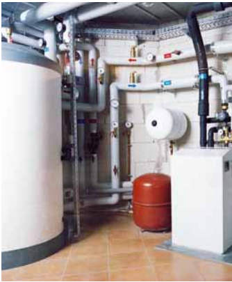
Wärmepumpe im Hausgebrauch
